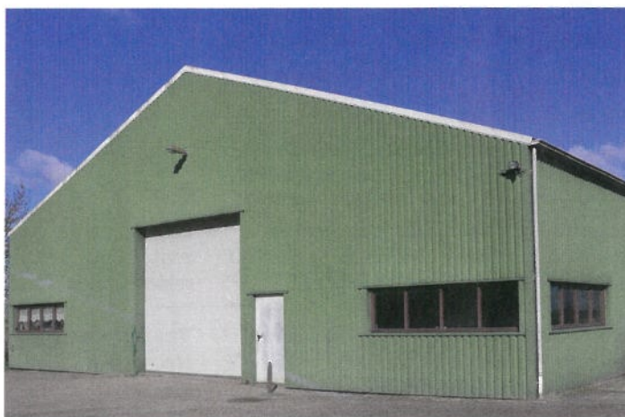
De landbouwloods uit 1995 is gebouwd van stalen damwandprofielplaten en deels drukvaste wanden. De oppervlakte is 1.000 vierkante meter bij een nokhoogte van 8 meter.
